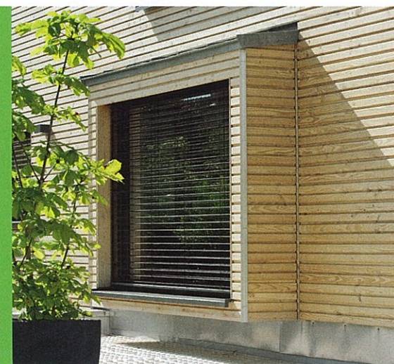
Lieblingsplatz von außen: Das Lese Fenster schiebt sich wie ein kleiner Erker aus dem Hauptbaukörper. Hier lässt sich im Detail die sorgfältige Ausführung der naturbelassenen Holzfassade erkennen.
